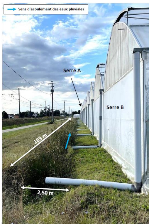
Fossé périphérique longeant les serres A et B
