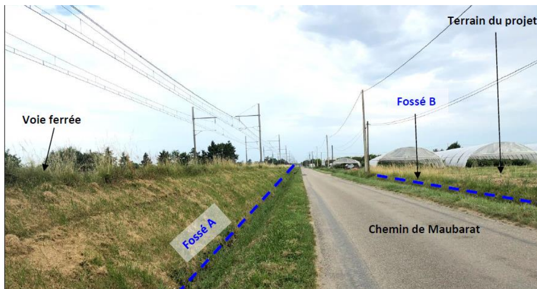
Chemin de Maubarat et fossés existants (GESOLIA, le 16 juin 2021)
