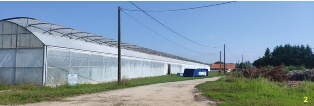
Voie de passage entre les serres vers la zone de tri, de stockage et de chargement (crédit photo : Néodyme)
