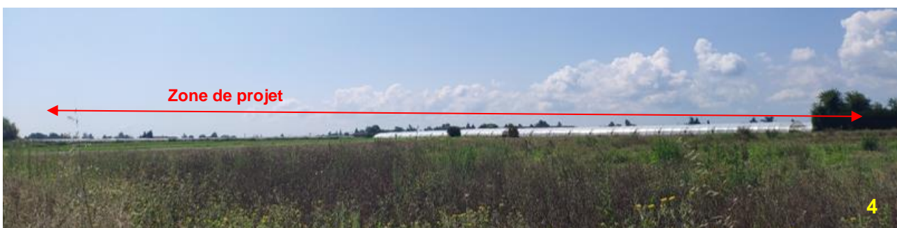
Vue sur les serres existantes et sur la zone de projet depuis le Nord-Est (crédit photo : Néodyme)
