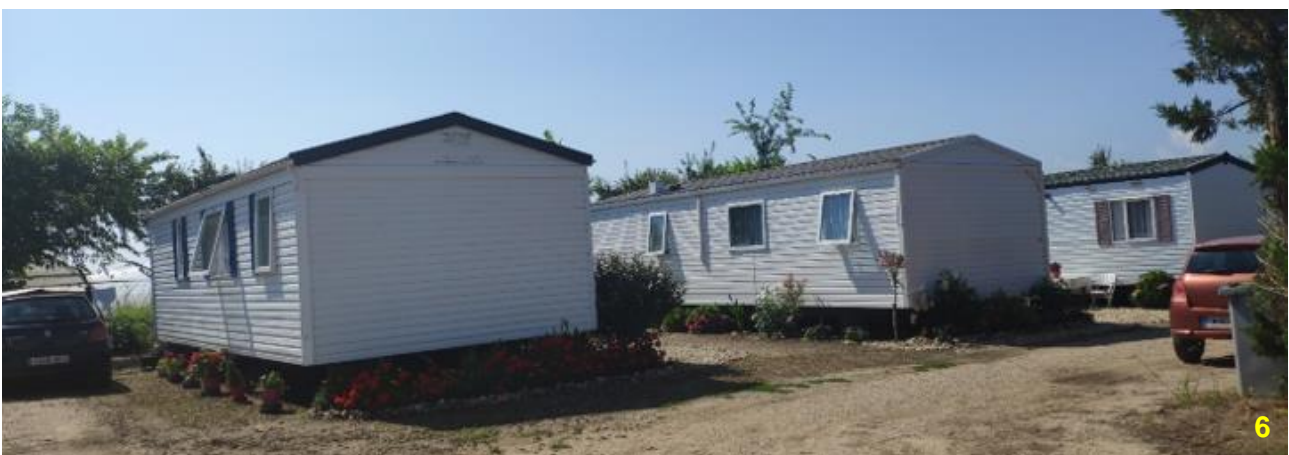
Vue sur les habitations accueillant le personnel saisonnier au cœur de la zone de projet (crédit photo : Néodyme)
