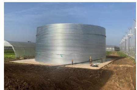
Cuve de récupération des eaux d'arrosage pour réutilisation (Source : cliché Monsieur TOPPAN)
