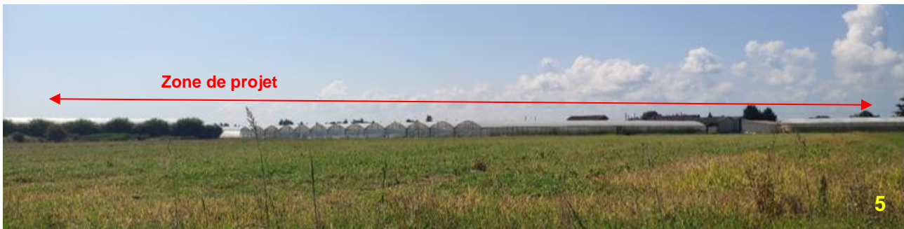
Vue sur les serres existantes depuis le Nord-Ouest (crédit photo : Néodyme)
